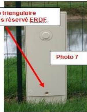
Branchement aéro-souterrain
