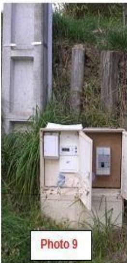
Compteur et disjoncteur dans coffrets extérieurs (généralement dos à dos)
