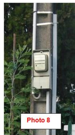
Compteur extérieur apparent
